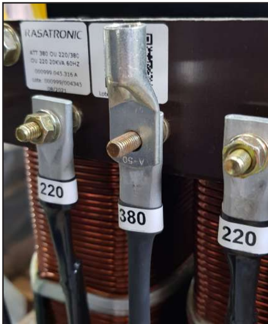
Figura 4 Colocação do terminal do cliente
